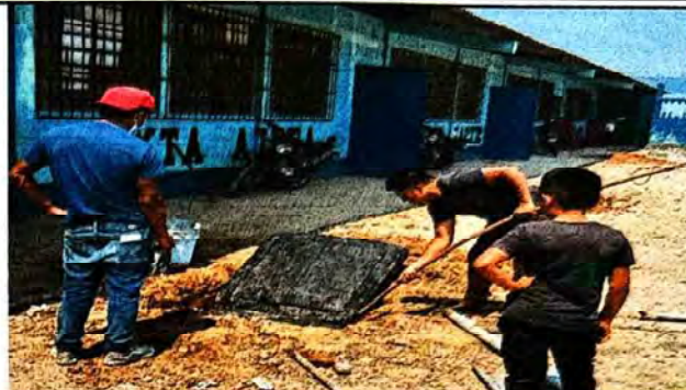
Foto 8: Reestructuración de red de drenaje y cambio de tubería de aguas negras.
