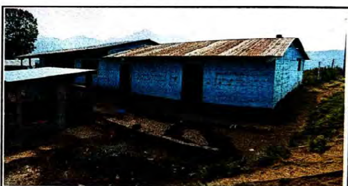
Foto 4: Sustrucción de estructura de techo del área de dirección.
