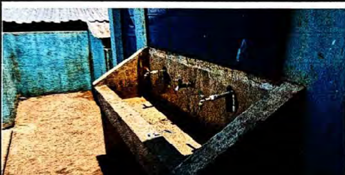
Foto 9: Cambio de accesorios de agua potable para lavamanos y área de baños.
