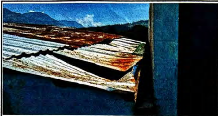
Foto 1: Sustrucción de estructura de techo en área del aula 10 y de los baños.
