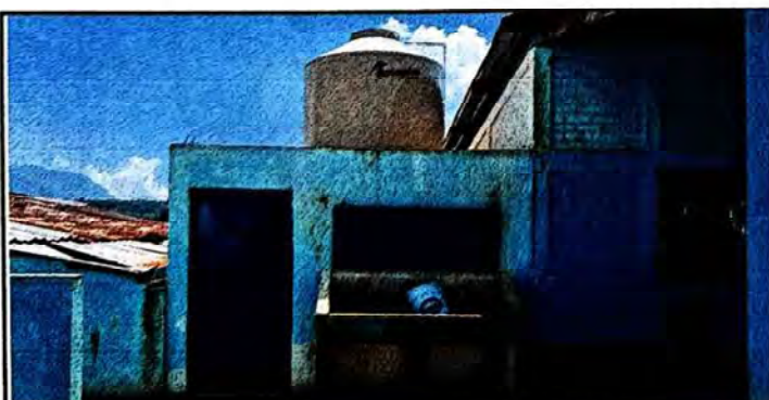
Foto 11: Construcción de bases para almacenamiento de agua y ampliación de áreas sanitarias.
